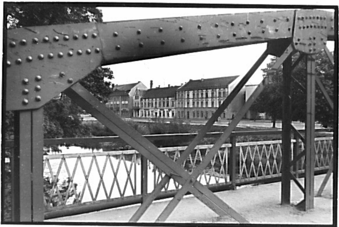
4 nuotr. Metalinės konstrukcijos. Fotografavo B.Šnarauskienė 1993 m.
