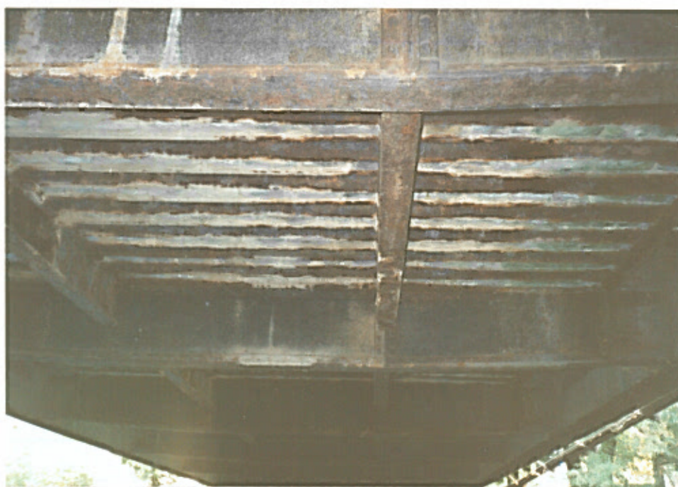
6 nuotr. Tilto važ. dalies konstrukcijų vaizdas iš apačios. Fotografavo V.Viršilas 1994 m.
